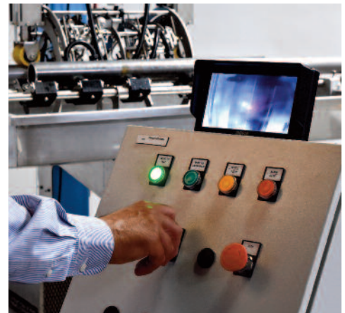
La estación remota del operador incluye los controles esenciales y el monitor para verificar la posición de los transductores con relación a la soldadura y el control tipo “joystick” para efectuar los ajustes.
