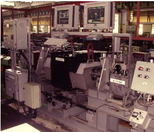
Contrôle de tube utilisant une tête rotative ultrasons Echomac montée sur table d'élévation, Démagnétiseur pour éliminer le magnétisme résiduel et un contrôle avec appareil de la série des MAC avec bobine encerclante.
